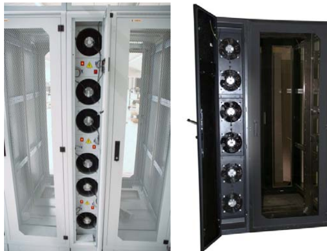
Seitliche Klimatisierungsmodule
