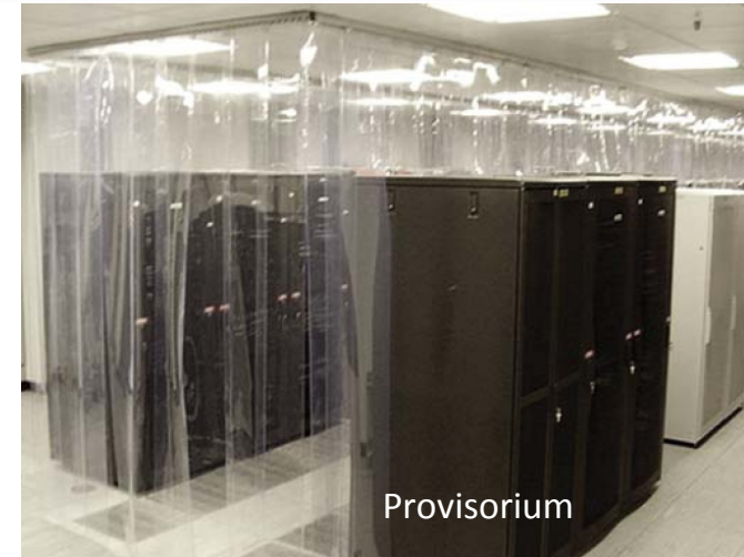
Kaltgangeinhausung (Doppelboden erf.)
